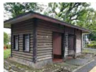
新高島平駅前公衆トイレ
